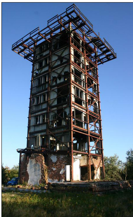
Takto vypadala strážní věž Havran před rekonstrukcí (zdroj: www.rozhlednahavran.cz )
