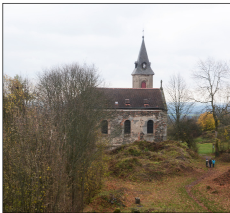
Zříceninu i kostel na Krasíkově začali opravovat
