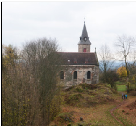
Zříceninu i kostel na Krasíkově začali opravovat
