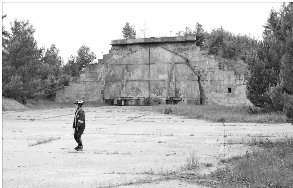
Geo před hangárem na letadlo, letiště Mimoň
