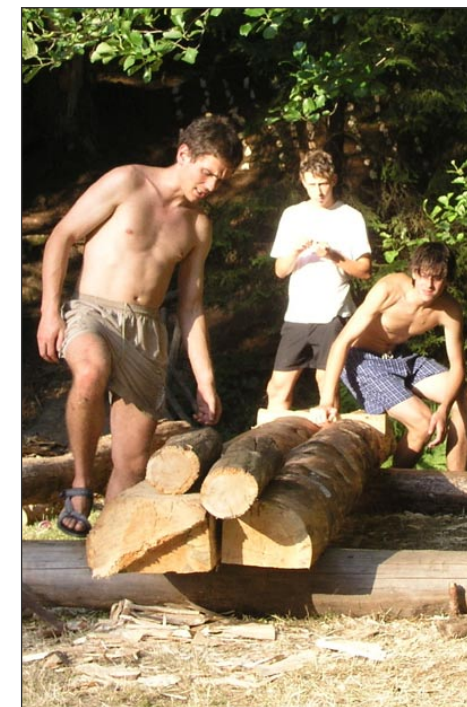
Budování nové lávky
