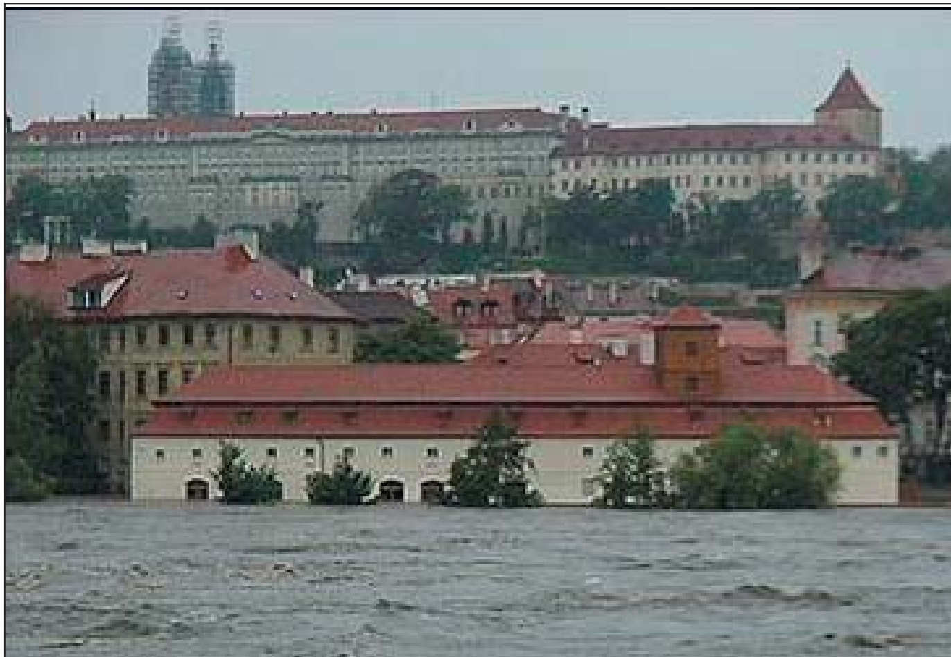
Takhle to nevypadá, ale ten dům je opravdu ve vodě
