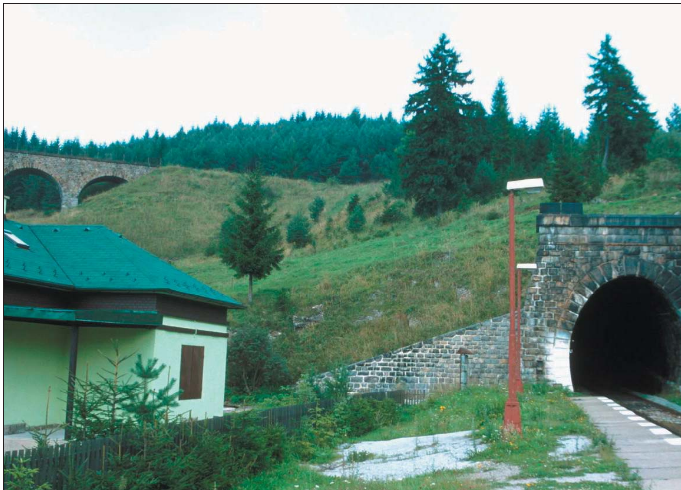
Super maďalova trať: z tunelu to pak vyjede tamhle na mostě
